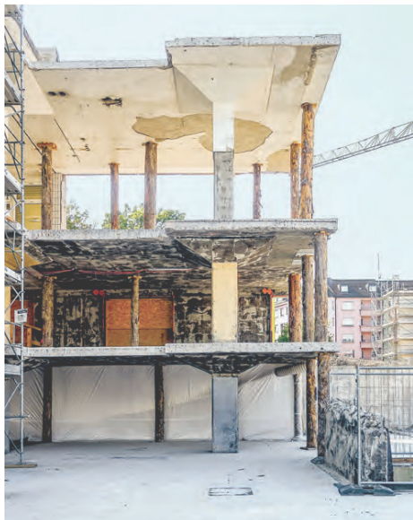
Die Geschosse wurden durch Holzstützen temporär abgestützt.
